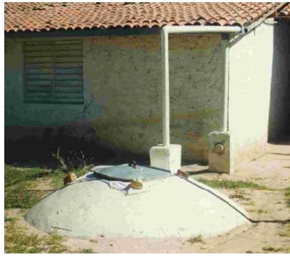
Figura 25 - Cisterna de tijolos e argamassa de cal enterrada
